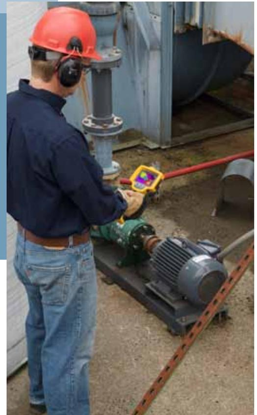
El aumento de calor se hace visible con una cámara termográfica Fluke Ti32, que capta imágenes bidimensionales de la temperatura superficial aparente de bombas y otros equipos.
