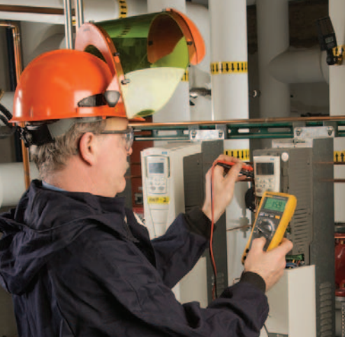
电气工头 Jim Murphy 使用 Fluke 179 DMM 在未 40 多年的旧系统新安装的 VFD 中观测低电压信号。
